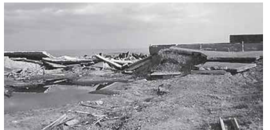
壊れた堤防からは海水が…… (2013年1月)
