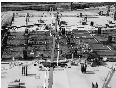
1階の床にコンクリートの流し込みを行っています
