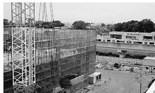
3階の床が半分作られ、つくばエクспレスの高架を超えた新東葛病院
