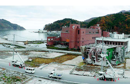
壊滅的被害の女川町・港 高台の女川町立病院から望む
