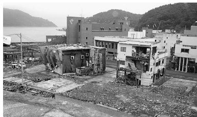
大震災で壊滅的な宮城県・女川町 (2011年当時)
